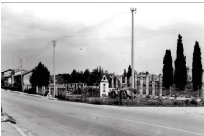
Fig. 14. Aquileia. Foro romano orientale fine anni '70, inizio lavori di demolizione case espropriate.
