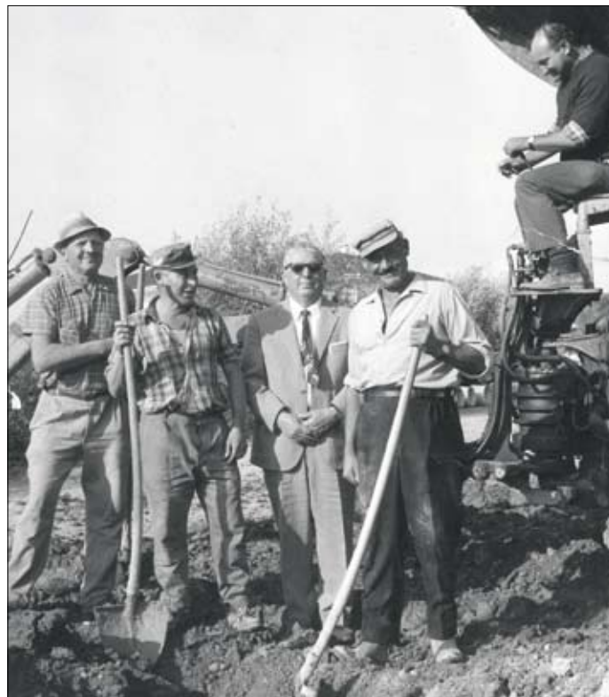
Fig. 34. Aquileia, collettore – 1969. Operai con l’impresario Carlet durante i lavori delle fognature.
