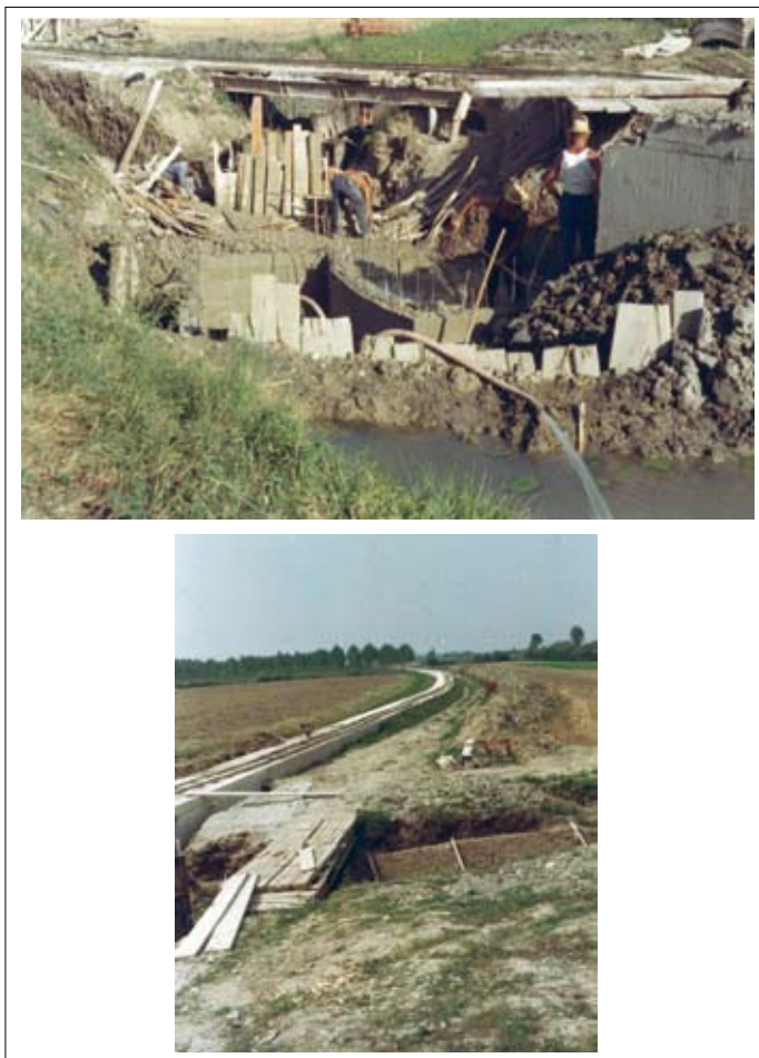
Fig. 1a-b. Lavori collettore fognature capoluogo di Aquileia.
