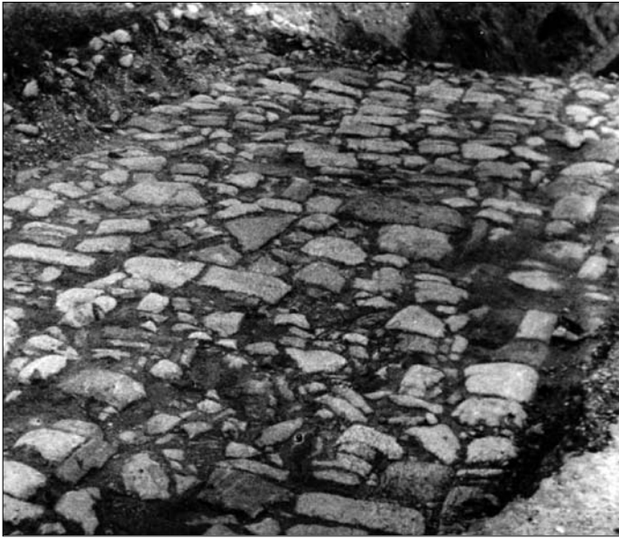
Fig. 17. Tratto di strada rimessa in luce in via XXIV Maggio, a nord della chiesa di S. Giovanni (foto M. Buora).
