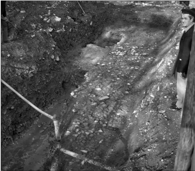
Fig. 19. Veduta di un tratto della massiccata della strada che costeggiava a ovest la chiesa di S. Ilario (MAN Aquileia, Archivio fotografico, inv. n. 5005, 198).
