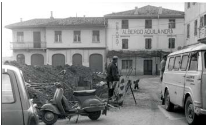
Fig. 33. Aquileia, piazza Garibaldi – 1969. Operai dell’impresa Carlet durante i lavori delle fognature.
