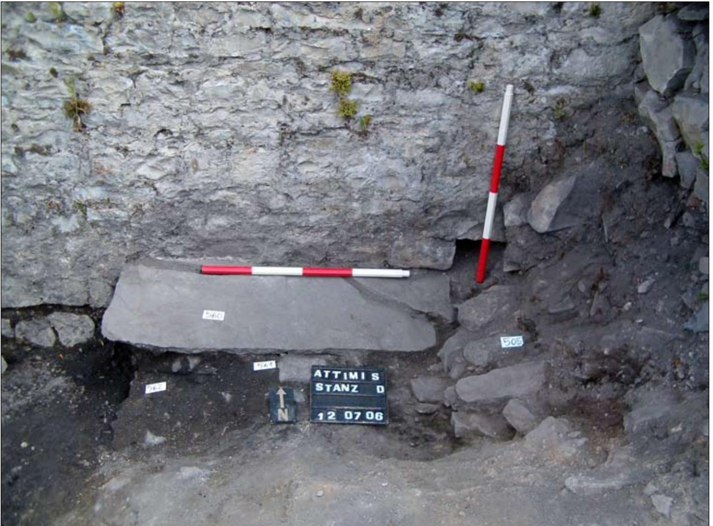
Fig. 17. La lastra US 560 inserita nel perimetrale nord (foto M. Lavarone).
