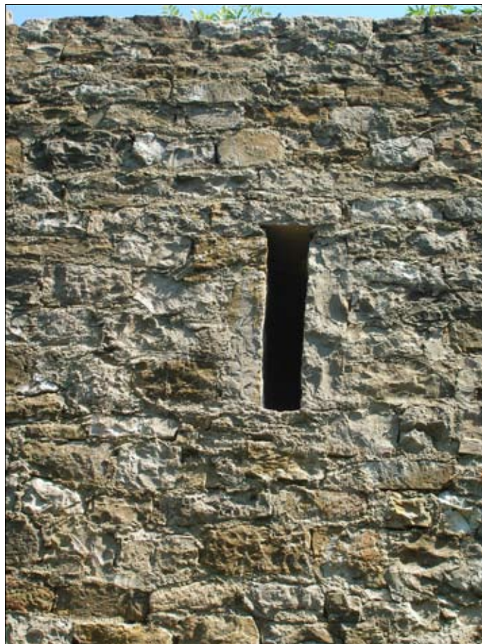
Tav. X, 1. La feritoia aggiunta nella parte ricostruita della parete occidentale (foto M. Lavarone).
