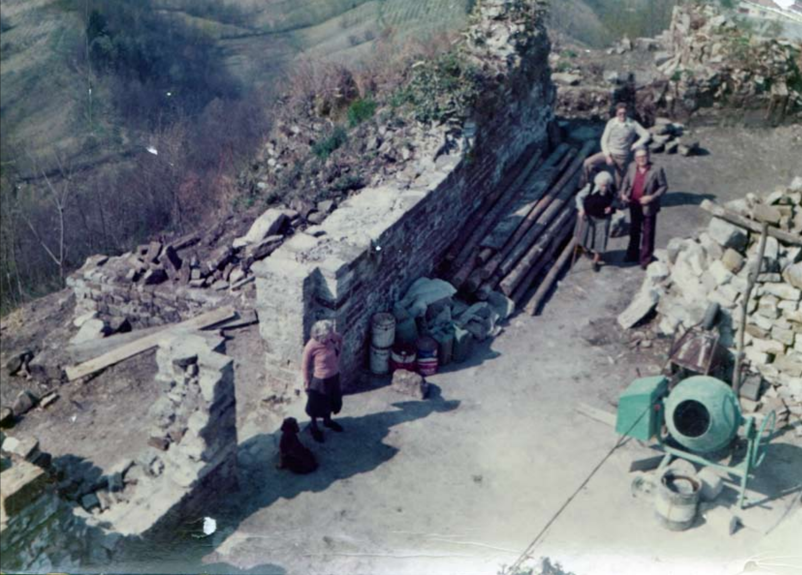
Tav. XII. Veduta dall'alto del mastio del medesimo settore. La parte occidentale del muro è già stata ricostruita e sulla destra si vede un mucchio di pietrame, pronto per il reimpiego (foto messa a disposizione dal sig. Cencig)..
