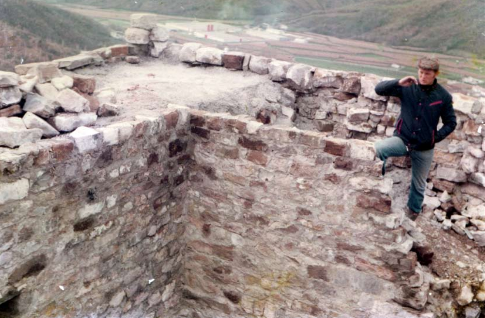
Tav. IX. Nella foto il sig. Franco Cencig sopra la muratura addossata. Si noti la tecnica a sacco con riempimento contenente molto cemento (foto messa a disposizione dal sig. Cencig).
