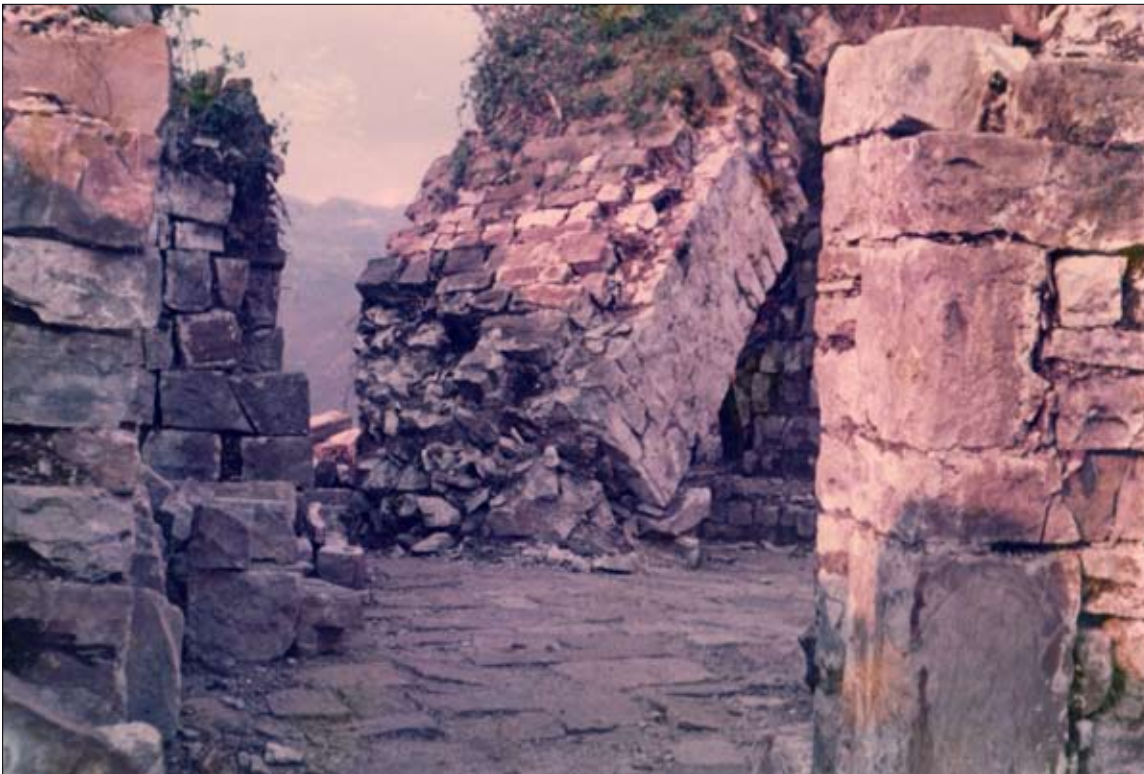
Tav. IV, 2. In fondo parte della parete settentrionale del mastio, crollata (foto messa a disposizione dal sig. Cencig).
