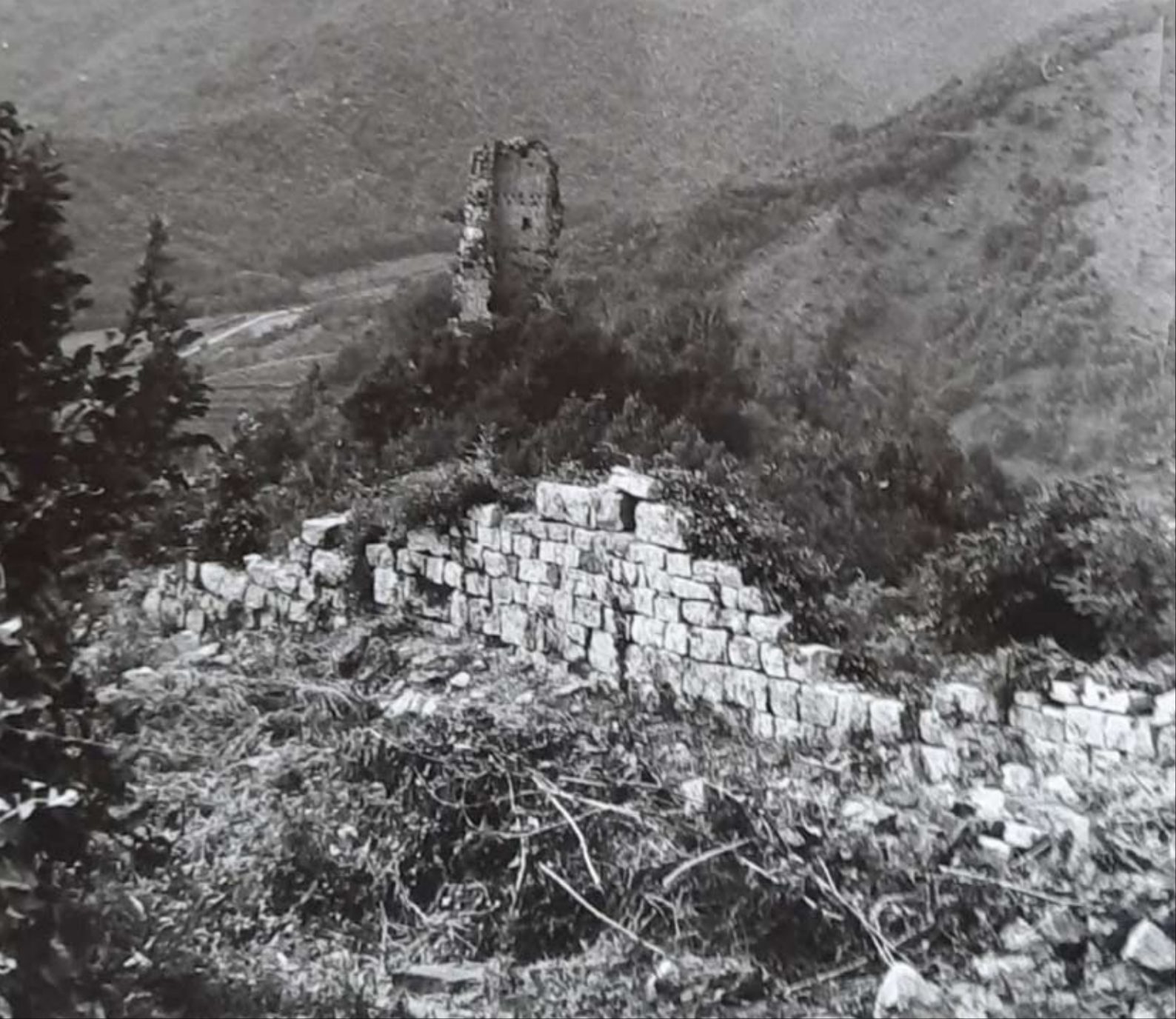
Tav. XVII. Il muro di cinta settentrionale, liberato dalla vegetazione che lo ricopriva, negli anni Settanta. A sud di esso si vede il terreno rimosso. Sullo sfondo il castello inferiore (foto messa a disposizione dal sig. Cencig).
