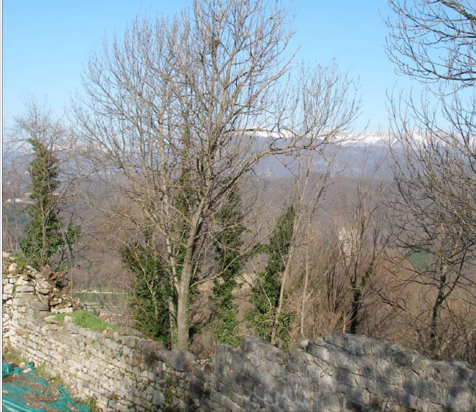
Tav. XVIII. Nella parte sinistra la sopraelevazione del muro di cinta settentrionale effettuata negli anni Settanta (foto M. Lavarone).
