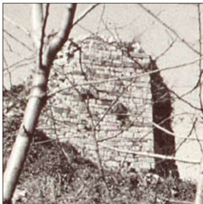
Tav. III, 3. La parte originaria del mastio, vista da sud (foto messa a disposizione dal sig. Cencig).
