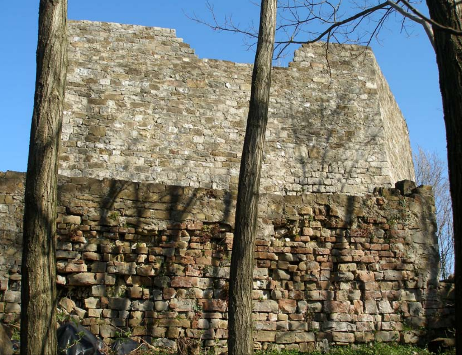
Tav. XIII. Il muro di cinta del castello, come appare oggi, dopo l'innalzamento degli anni Settanta (foto M. Lavarone).
