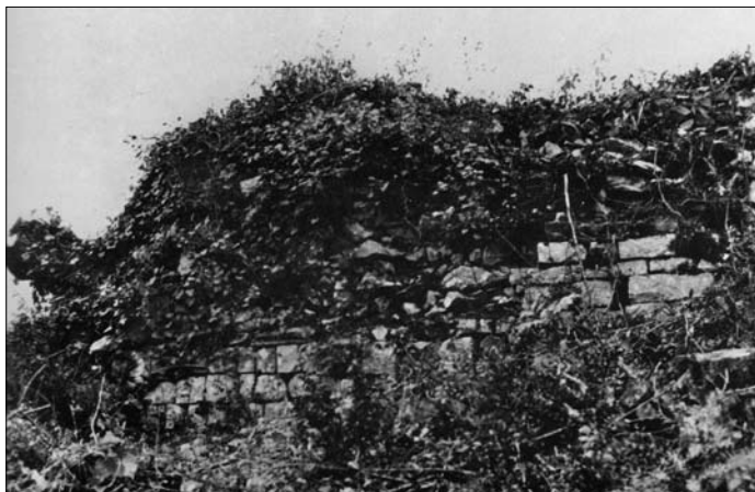
Tav. III, 1. Stato della muratura, coperta da rovi e terra, prima dei lavori degli anni Settanta (foto messa a disposizione dal sig. Cencig).
