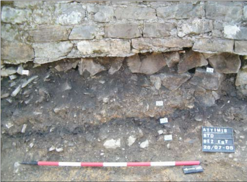
Tav. XV, 1. Un nuovo muro costruito negli anni Settanta, a delimitare l'area D (foto M. Lavarone).
