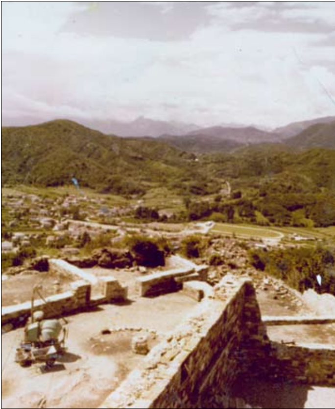
Tav XX, 1. Veduta dal mastio alla conclusione dei lavori (foto messa a disposizione dal sig. Cencig).
