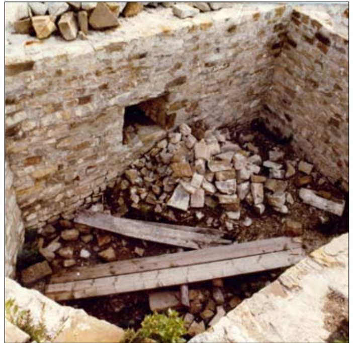
Tav. VIII, 2. All'interno viene addossata alle pareti una nuova muratura. Verso ovest si lascia libero un quadrato per ospitare la feritoia verticale (foto messa a disposizione dal sig. Cencig).
